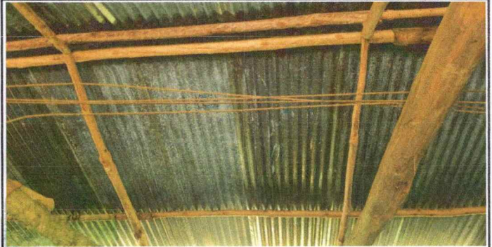
Foto 2: Cambio de techo Preprimaria
