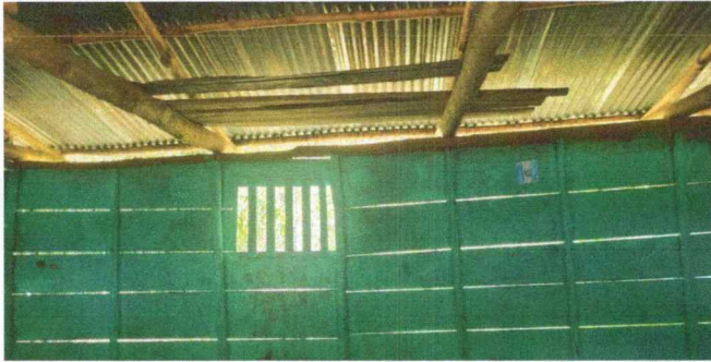
Foto 1: Construcción nueva escuela Preprimaria
